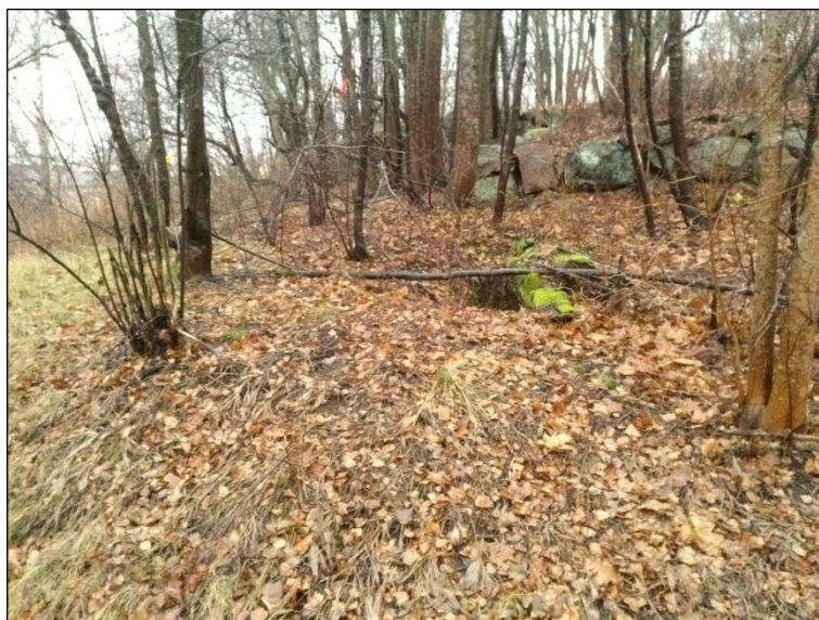
Maanalainen rakenne alueen eteläosassa, kivipenkereen länsipään eteläpuolella. Kuvassa näkyvästä reiästä erotti onkalon sekä siellä rautaputkea (betonirautaa?) ja betonirakennetta.
