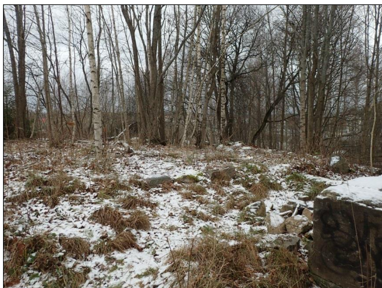
Rakennuksen perustaa pohjoiseen, oikealla porras.
