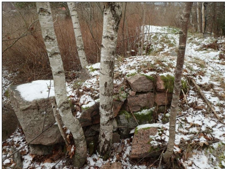
Rakennuksen perustan luoteispäätä
