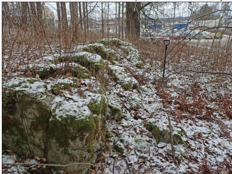
Länteen. Rakenne on oletettavasti parenteesin aikana tehty.
