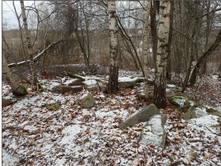
rakennuksen perustan koilliskulmaa, koilliseen.
